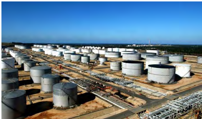
Galp refinery in Porto (Portugal).
