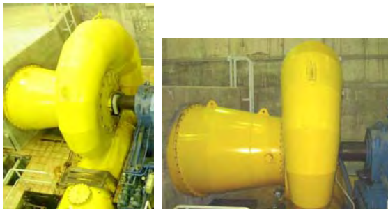
Fig. 9: Fotografía de la turbina Francis
