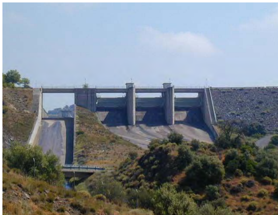
Fig. 1: Vista frontal de la presa
