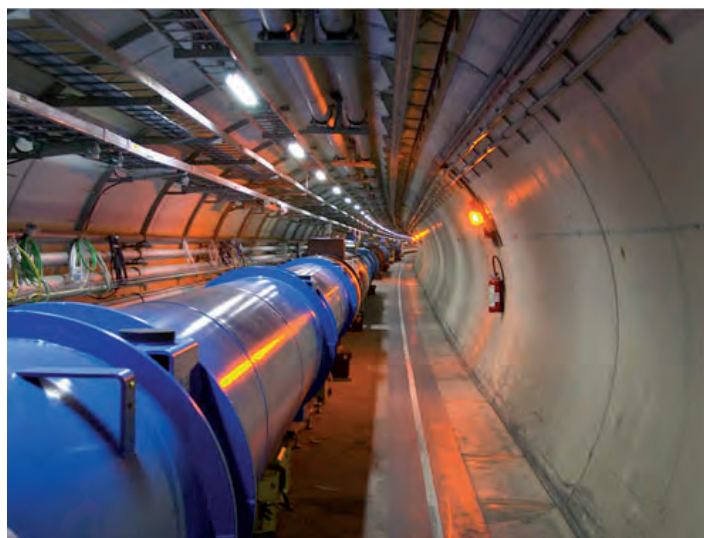
Túnel del LHC.
